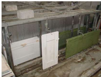
Foto II: Fensterläden vor dem Ablaugen
